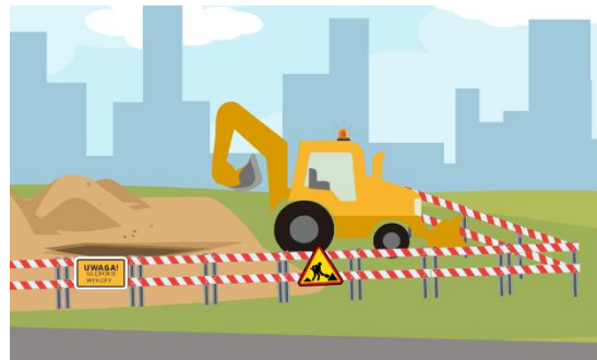
Rysunek 1 Wygrodzenie i oznakowanie wykopów
